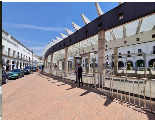
Imagen 20: Colocación de vallas en la periferia de la Plaza José María González Arratia para evitar el paso peatonal. Foto. https://mvt.com.mx/cierran-plaza-gonzalez-arratia-de-toluca-por-riesgo-de-derrumbe-210467/
