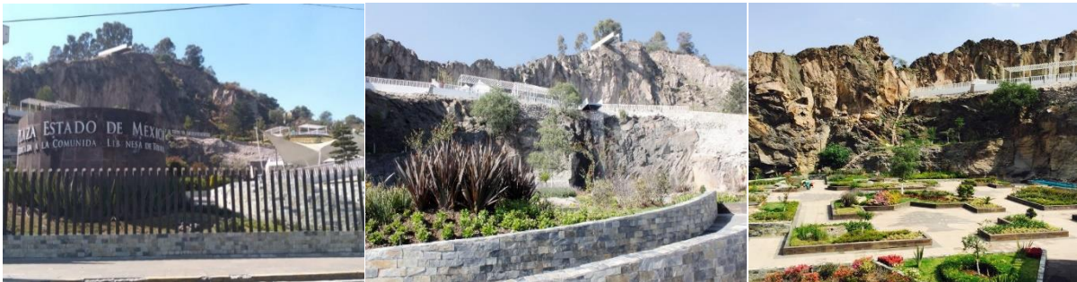
Imagen 37: Fotografías panorámicas de la Plaza Estado de México dedicada a la Comunidad Libanesa de Toluca. Foto: https://tolucalabellacd.com/2020/02/21/donde-ir/toluca-rehabilita-parque-libano-e-invita-a-visitarlo-en-familia/
